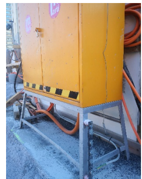
Abbildung 2: Quelle Firma Bau-Konzept
