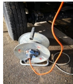
Abbildung 7: Quelle Firma Bau-Konzept
