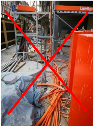
Abbildung 5: Quelle Firma Bau-Konzept
