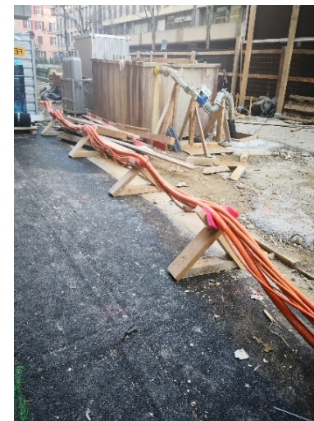
Abbildung 4: Quelle Firma Bau-Konzept
